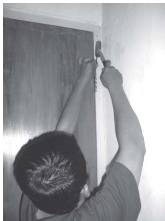
Gambar 7.1 Paku dibuat runcing agar mendapat tekanan yang lebih besar.
